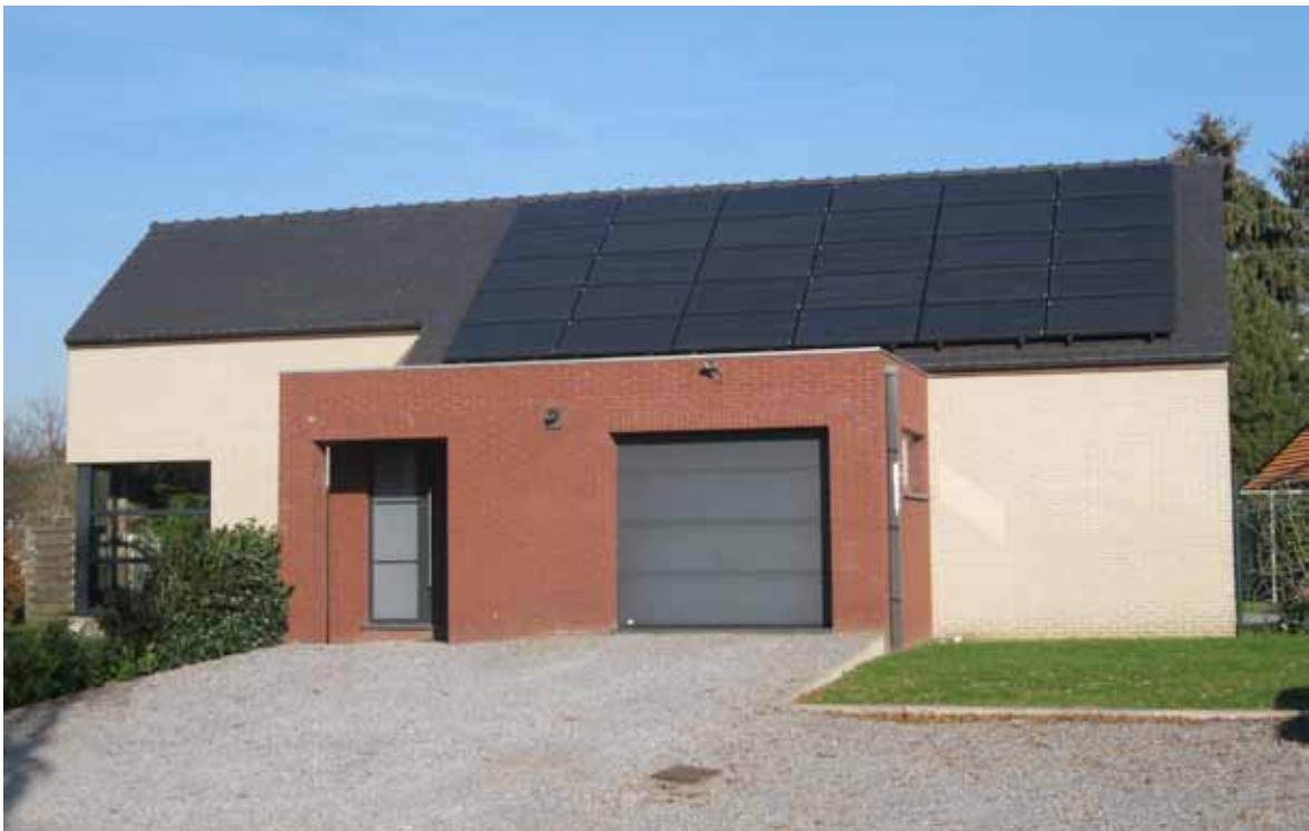
Residentiële installatie met zwarte panelen
