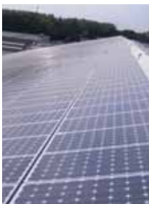
Installatie van 700 kWp Veiling Brava Asse
