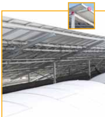
Plat dak met schans
