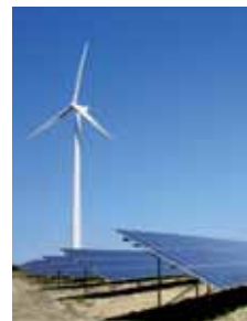
Zonnepark 1300 kWp Electrawinds Lombardsijde
